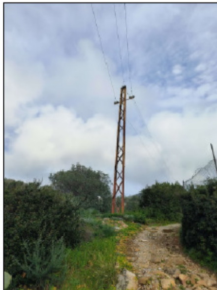
FOTO n. 20 traliccio M.T. 4 da rimuovere
