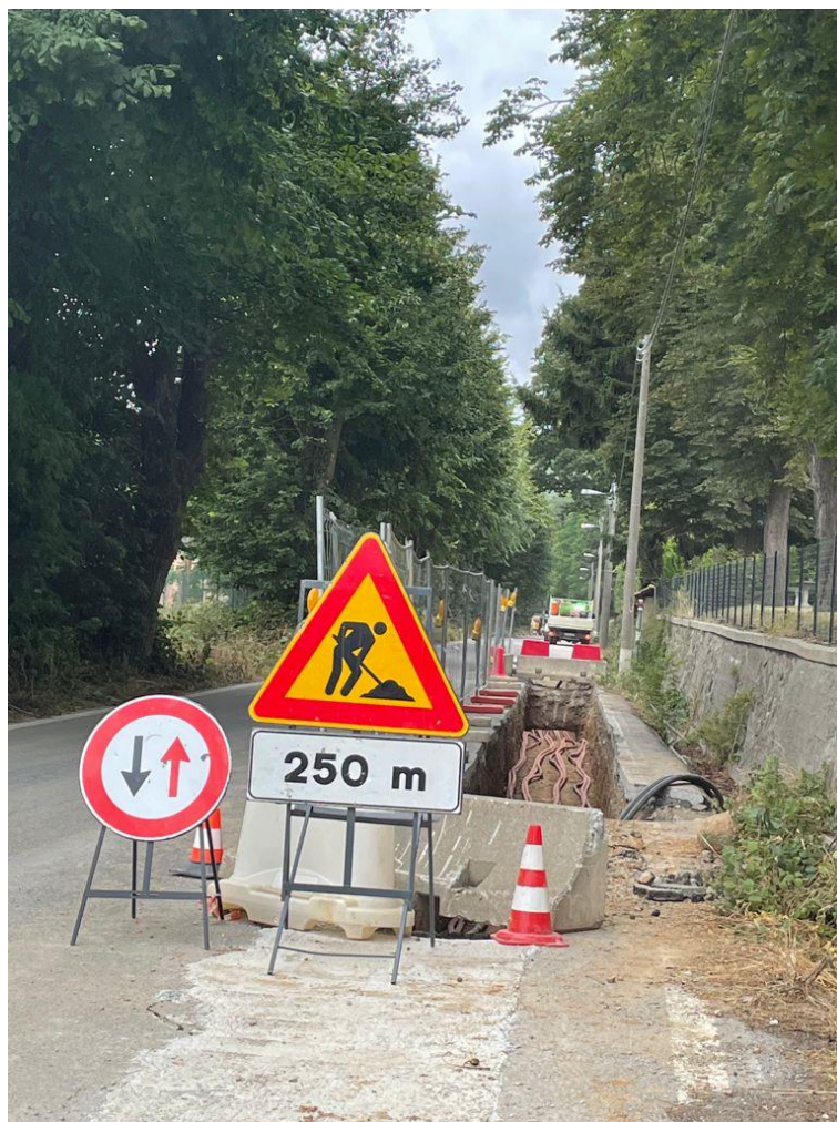
Cantiere per realizzazione cavidotto parco eolico; ; trincea eseguita per la posa dei cavi su strada asfaltata Provinciale in tratto extraurbano; trattasi di cantiere mobile in quanto ogni giorno lo scavo avanza di circa 100 metri ed il tratto completato viene ricoperto
