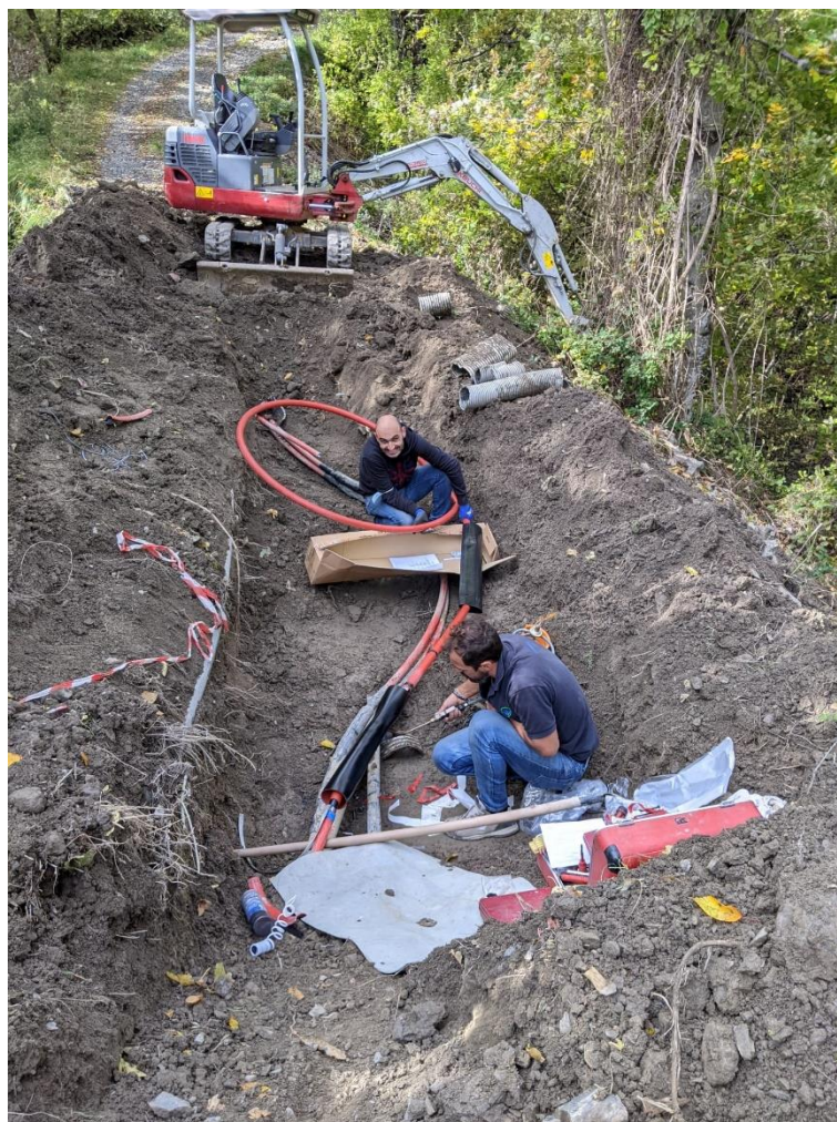
Cantiere per realizzazione cavidotto parco eolico; realizzazione giunto di connessione dei cavi; il giunto, una volta realizzato verrà coperto senza quindi necessità di utilizzo di tombini
