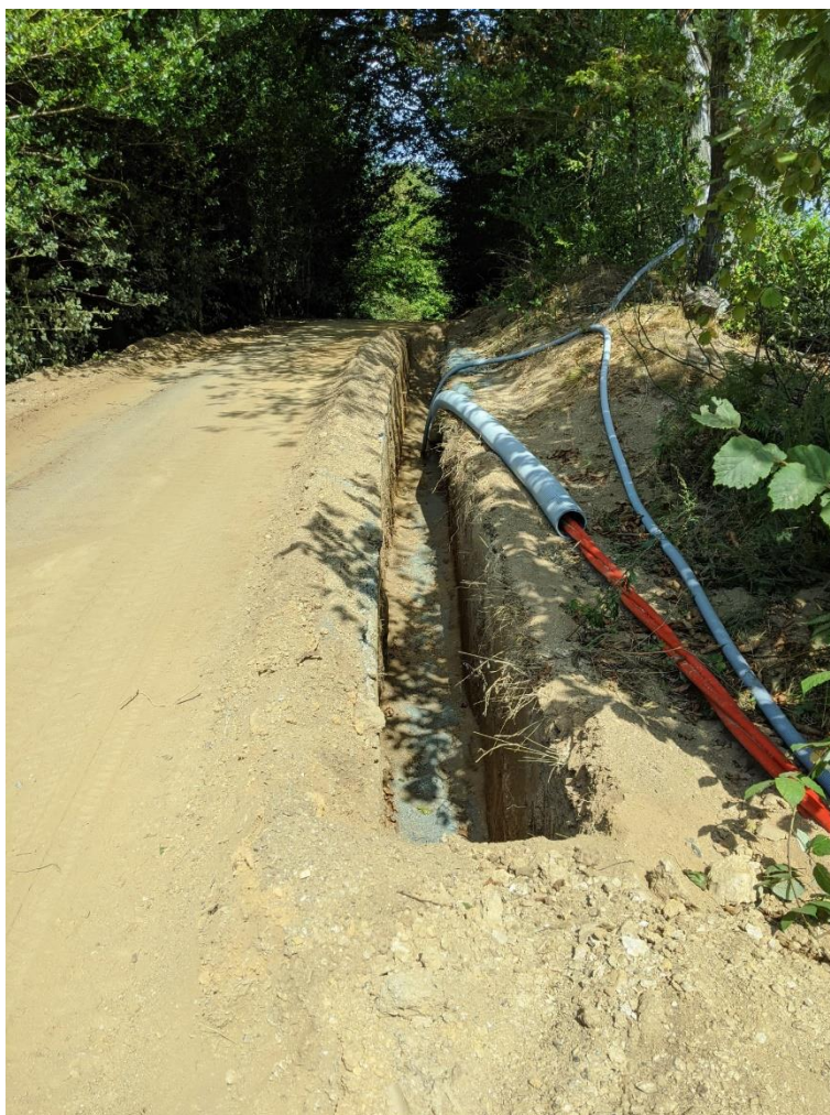
Cantiere per realizzazione cavidotto parco eolico; trincea eseguita per la posa dei cavi su strada sterrata in tratto montano boscato
