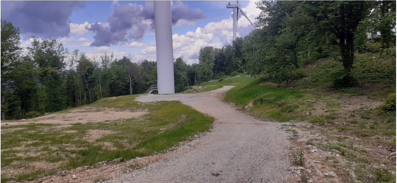
Tracciato del cavidotto del Parco eolico "Cascinassa" nel Comune di Cairo Montenotte (SV) di proprietà di FERA Srl; i cavi corrono lungo una strada sterrata in un tratto montano boscato, sono completamente interrati e privi di tombinatur
