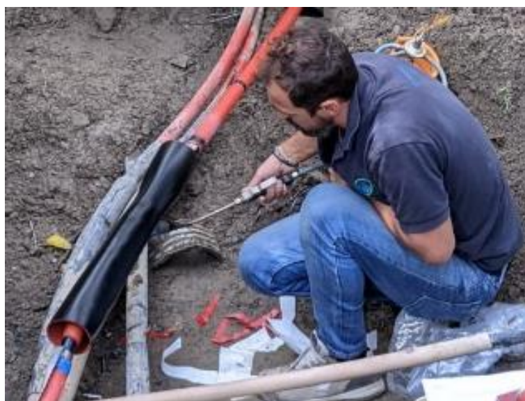
Dettaglio della fase di realizzazione di un giunto di collegamento interrato
