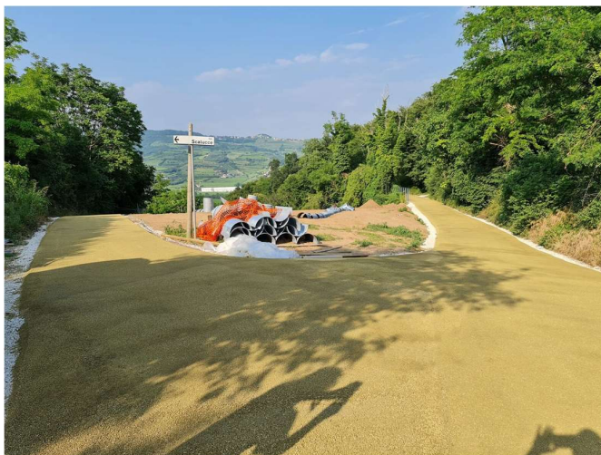
Figura 3 - Esempio di utilizzo di miscela "ecodrain" su una strada carrabile pubblica in ambito montano (colore giallo ocra); dal sito ufficiale https://www.ecodrainsrl.com/ a Colognola ai Colli (VR)
