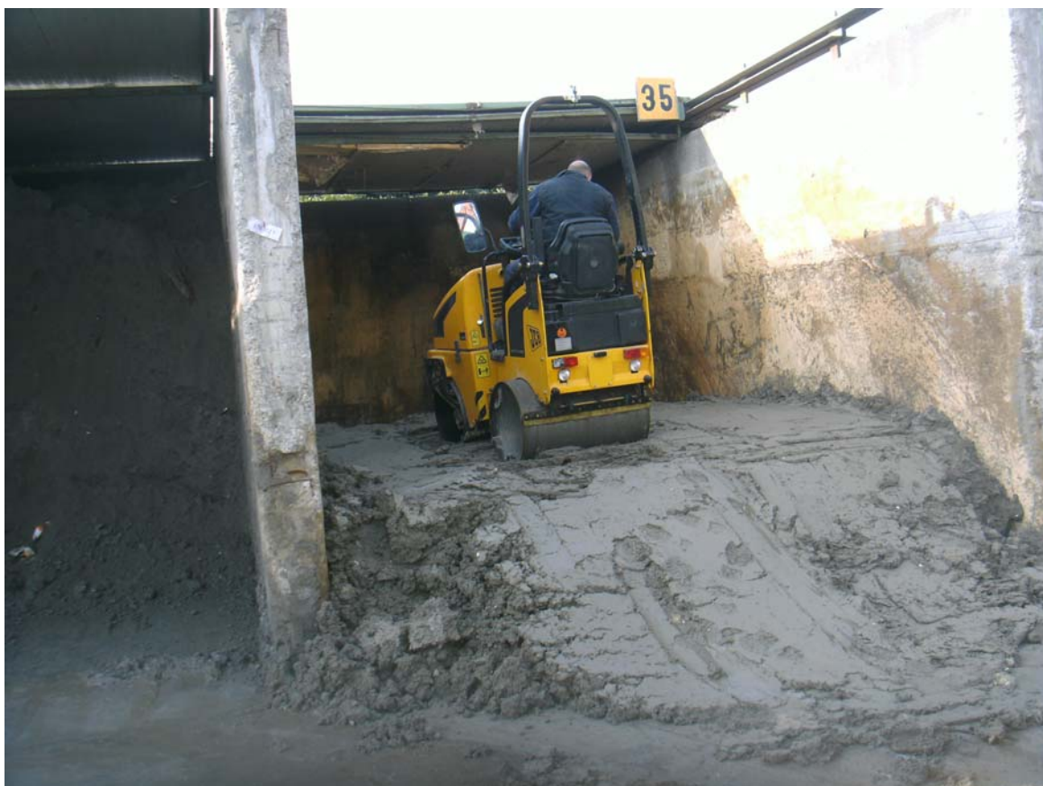
Foto n.7 Fasi di compattazione della "Miscela 1", con rullo JCB da 16 quintali.
