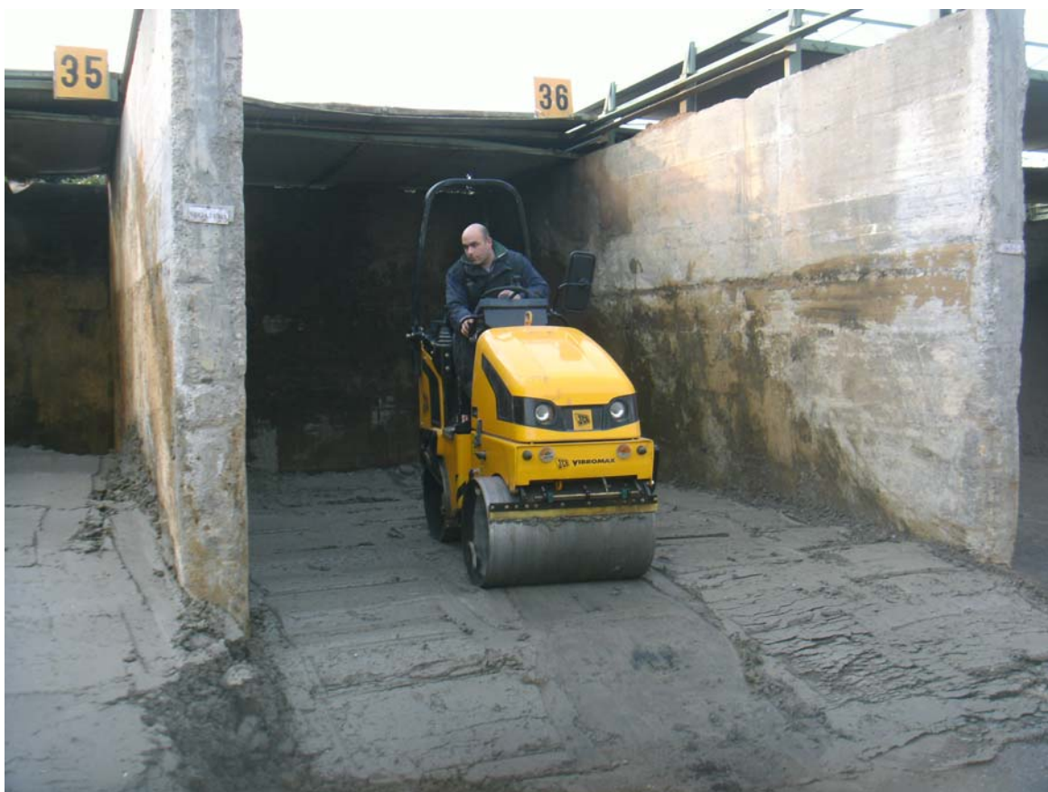
Foto n.8 Fasi di compattazione della "Miscela 2".
