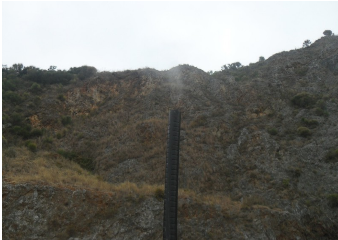
Fuoriuscita del tubo microfessurato posto all'interno del pozzo drenante
