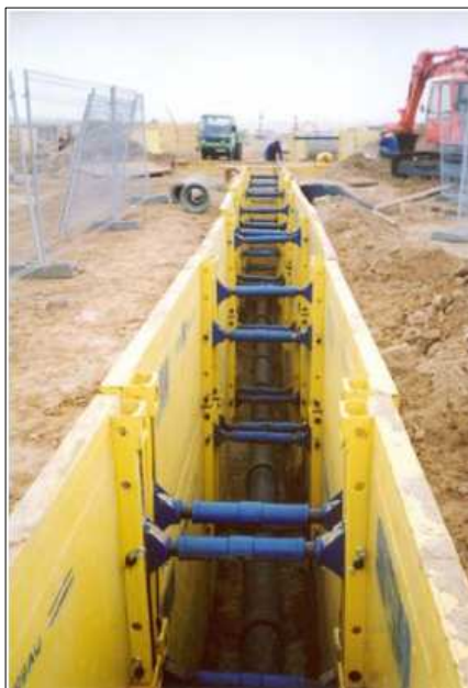
Figura 6-6 – Tipologico. Sistema di blindaggio degli scavi.
