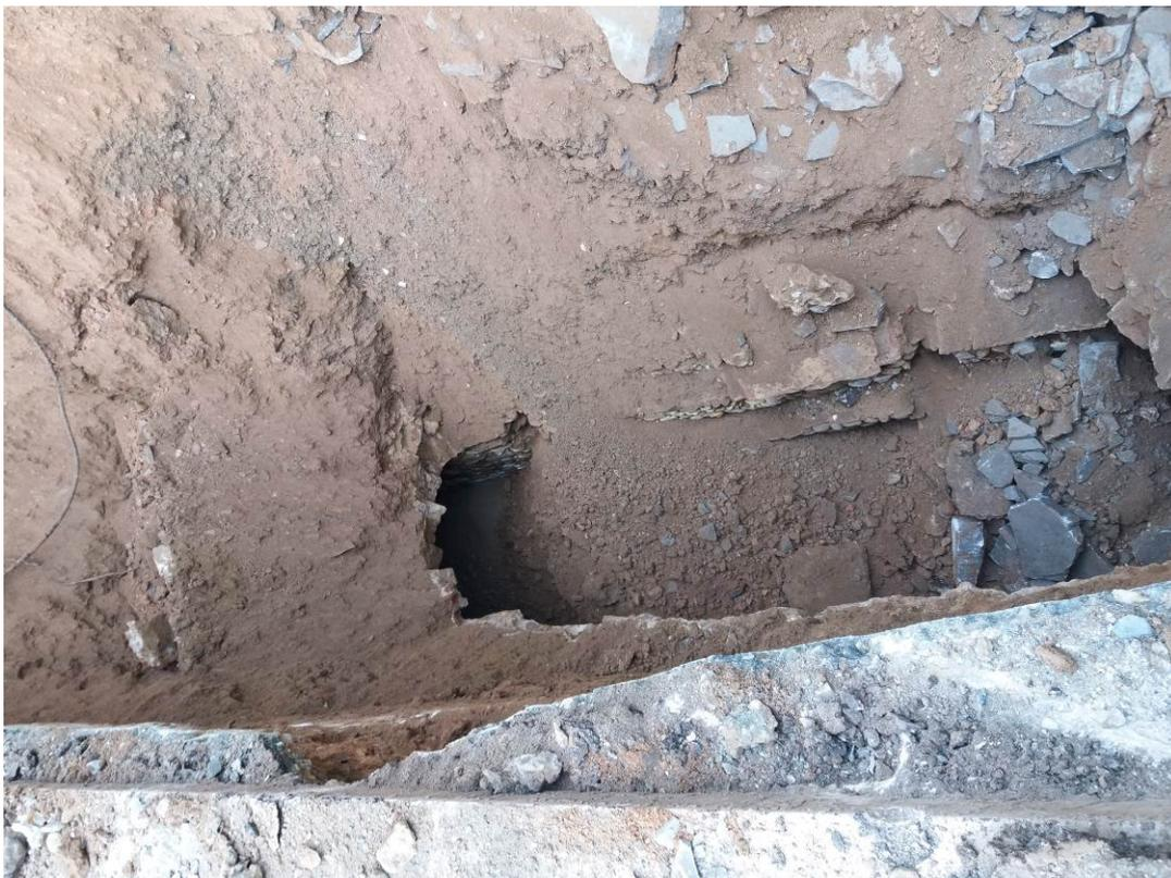
Figura 2 Lo stato dell'emissario Chiesi durante la fase di rimozione dei detriti. Visibile la copertura a volta franata
