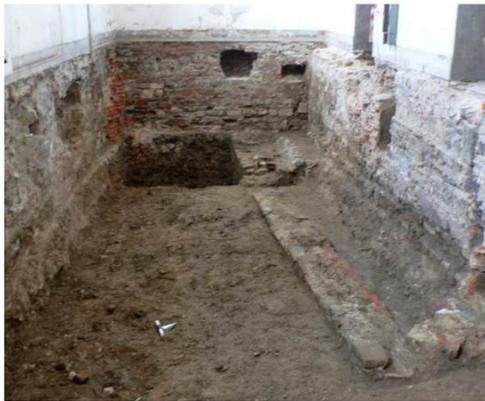
Figura 1 Il setto murario più antico rinvenuto al di sotto delle strutture del tiratoio
