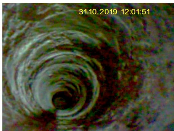
A circa 180-190 cm dal foro d'ingresso è visibile la presenza di conglomerato cementizio con aggregati eterogenei ed eterometrici. Nella foto è inoltre visibile il foro d'uscita.
