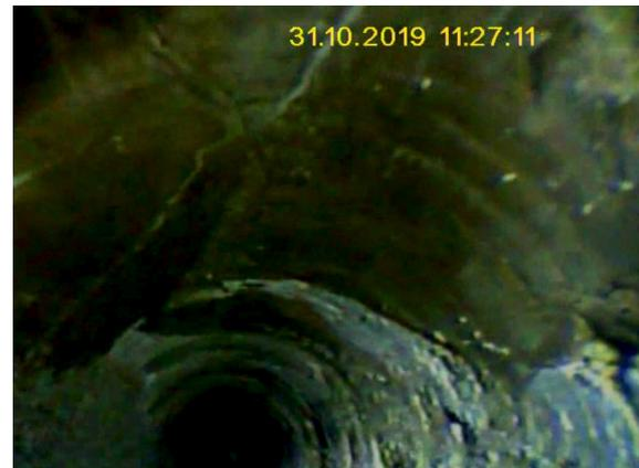
A distanza di 50 cm dal foro d'ingresso è visibile il passaggio tra il rivestimento in blocchi di pietra del paramento esterno e il conglomerato cementizio con aggregati eterogenei ed eterometrici.
