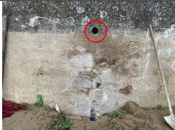
In corrispondenza della zona d'indagine il muro d'argine si presenta completamente intonacato ma appena sotto è possibile vedere la presenza di una muratura mista in blocchi di pietra e laterizi.
