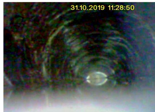
A circa 180-190 cm dal foro d'ingresso è visibile la presenza di acqua fino a circa metà altezza della sezione del foro. Nella foto è inoltre visibile il foro d'uscita.
