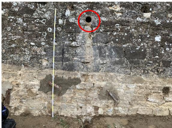
In corrispondenza della zona d'indagine il muro d'argine si presenta completamente rivestito in blocchi di pietra a conci sbozzati.
