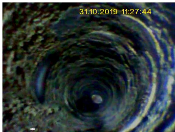
Conglomerato cementizio con aggregati eterogenei ed eterometrici con matrice non consistente.
