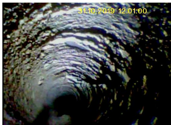
A distanza di 40 cm dal foro d'ingresso è visibile il conglomerato cementizio con aggregati eterogenei ed eterometrici e la presenza di ghiaia sabbiosa di colore marrone scuro.
