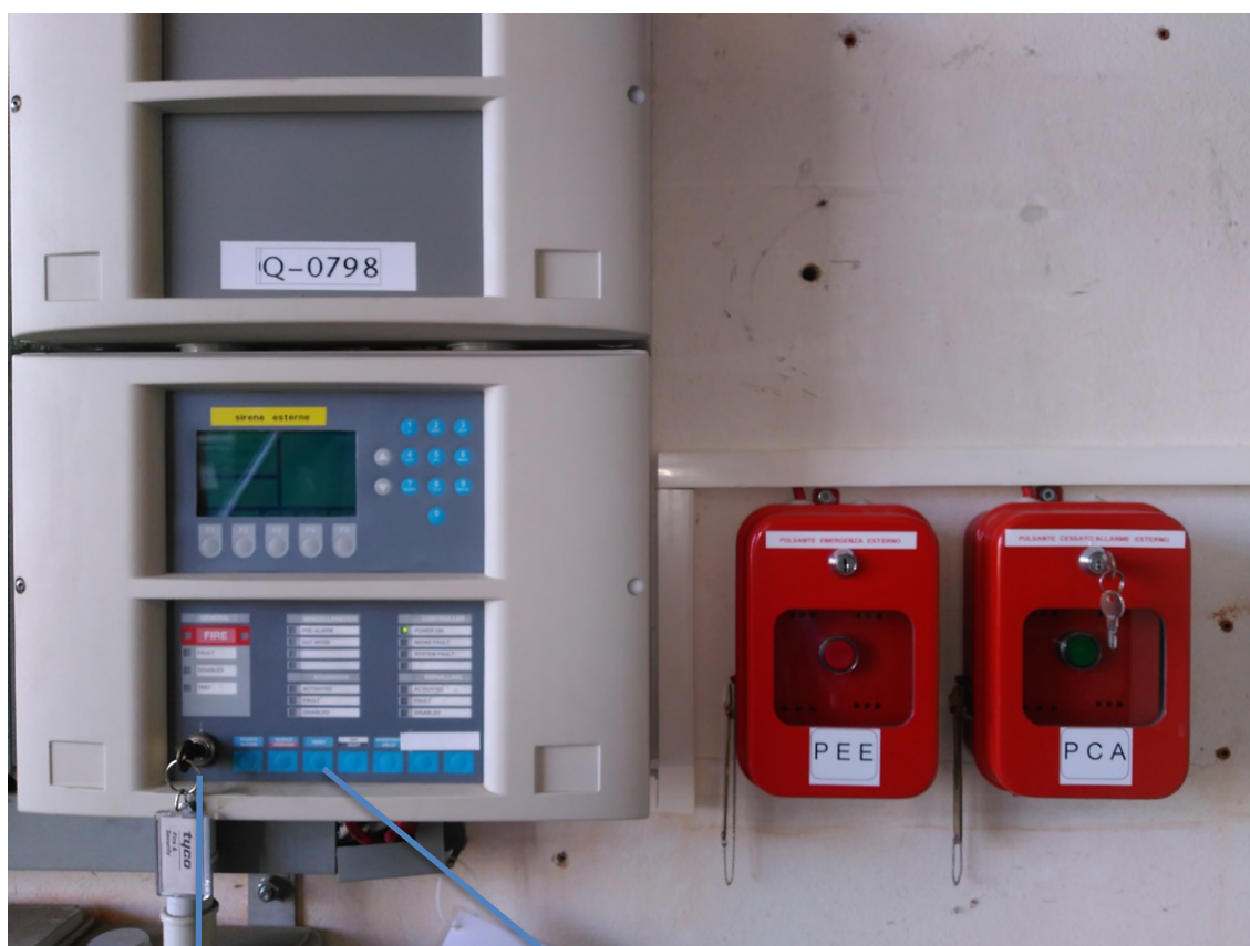
Figura 6 Centralina sirena esterna PEE
