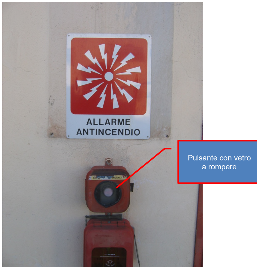
Figura 1: PULSANTE ATTIVAZIONE PIANO DI EMERGENZA INTERNO PRESSO MAGAZZINO ANTINCENDIO
