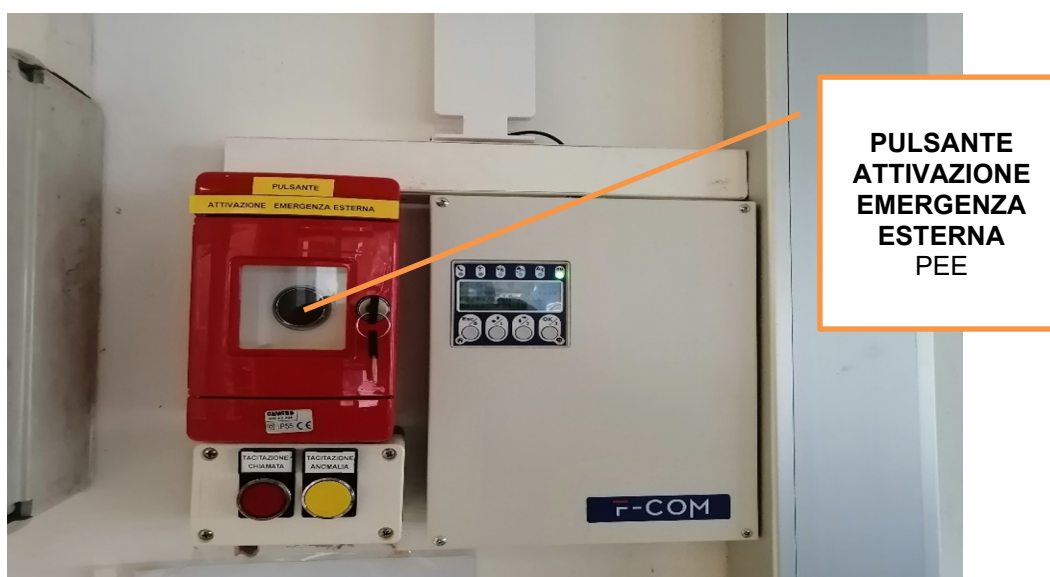
Figure 2: PULSANTE DI ATTIVAZIONE COMBINATORE
