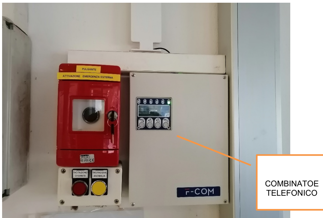
Figure 2: PULSANTE DI ATTIVAZIONE COMBINATORE
