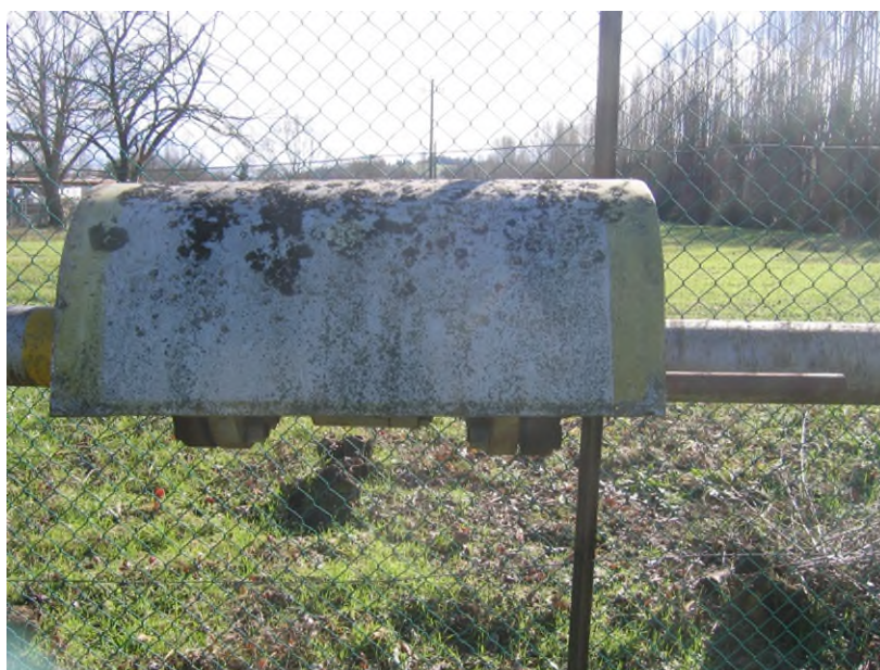
Figura 5: VALVOLA MANUALE SEZIONAMENTO LINEA GENERALE ARRIVO METANO IN STABILIMENTO
