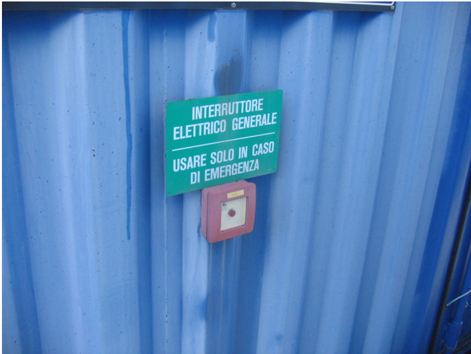
Figura 3: INTERRUTTORE GRUPPO ELETTROGENO
