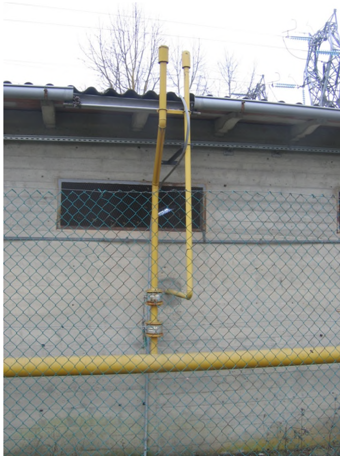
Figura 6: SFIATO PER DEPRESSARE TUBAZIONE METANO
