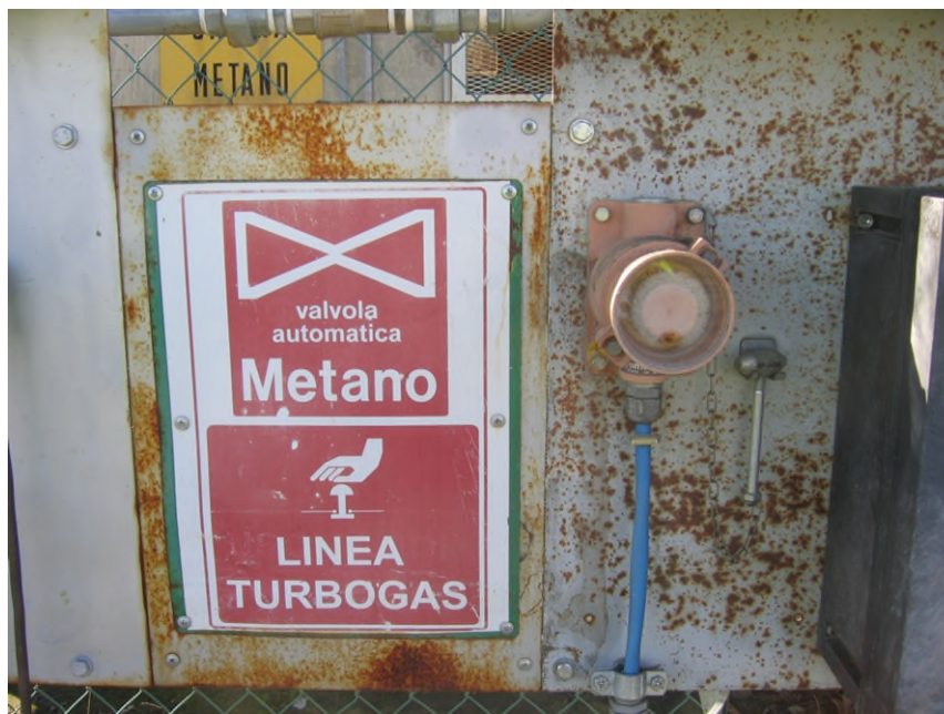
Figura 4: PULSANTE BLOCCO VALVOLA ALIMENTAZIONE METANO A TURBOGAS
