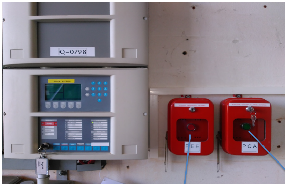
Figura 5 Pulsanti per attivazione sirene estere PEE e relativa fine emergenza
