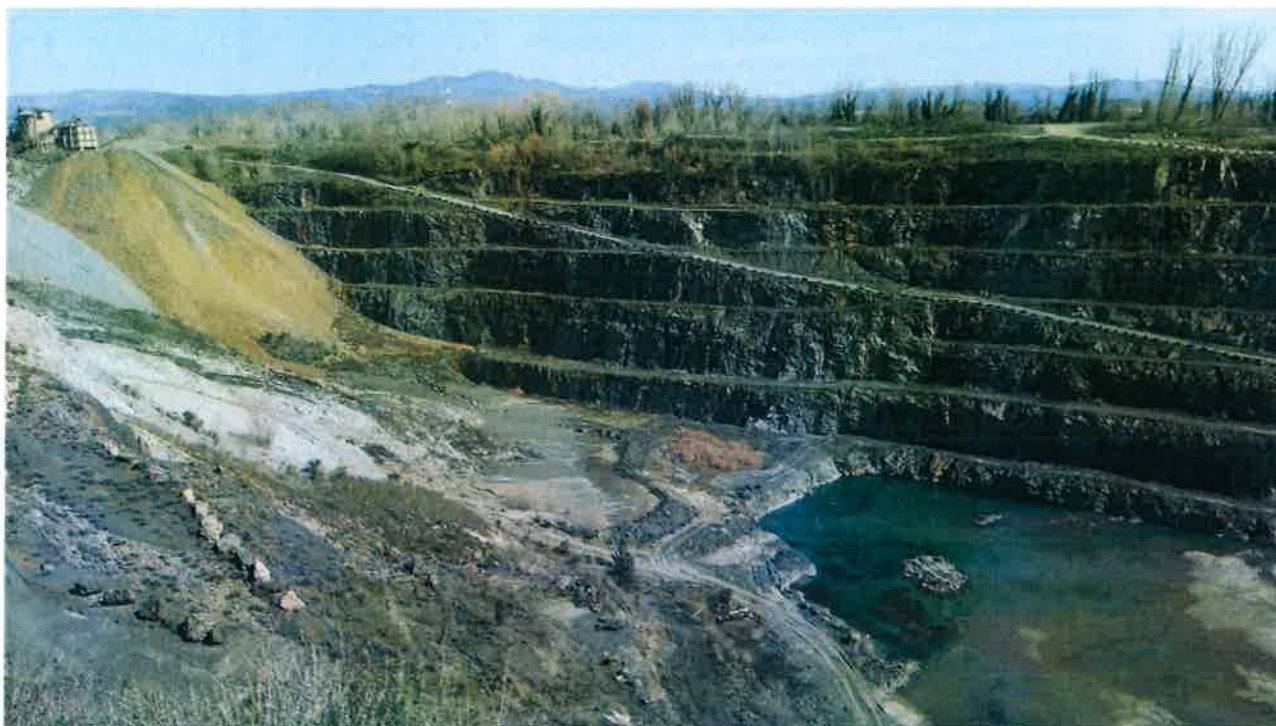
Foto 1: Panoramica di parte della gradonatura Est con vista della discarica terrigena (in alto a sx) e del fondo scavo allagato (in basso a dx)
