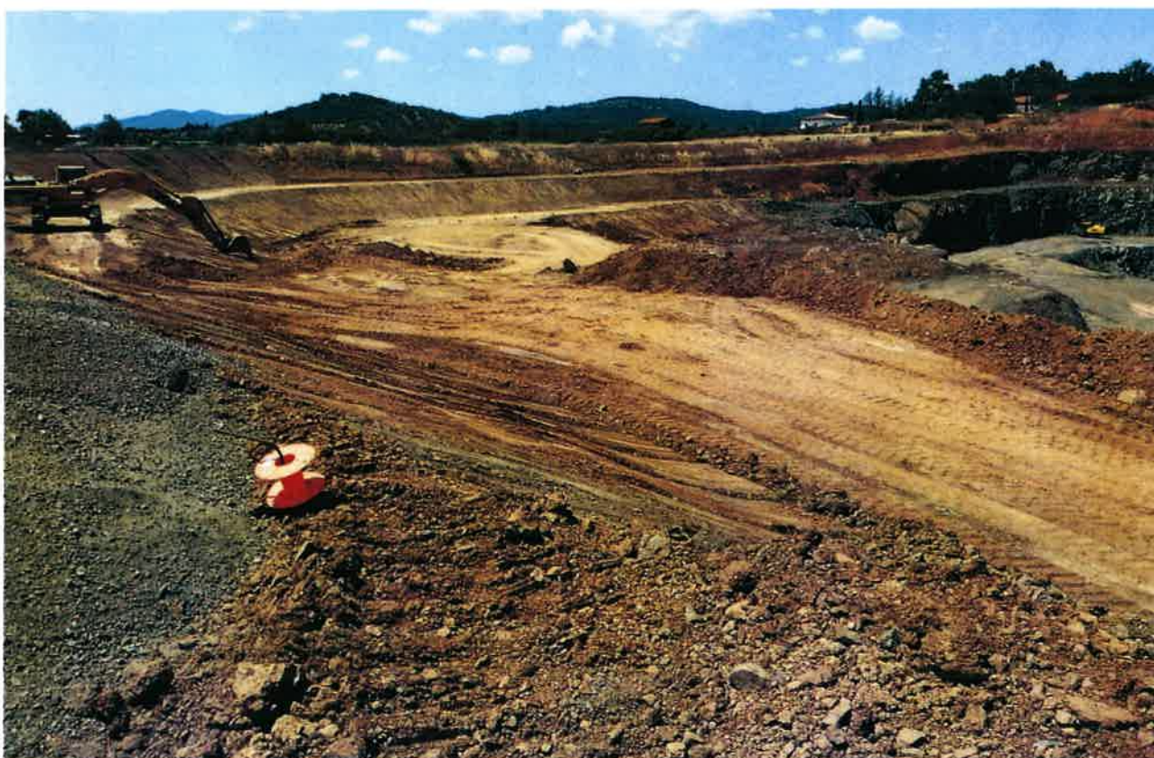
Foto 6: Lavori di realizzazione delle scarpate sommitali nel settore SE
