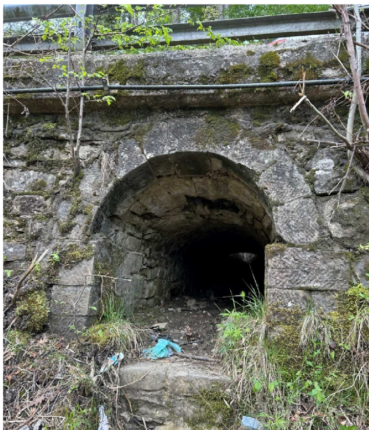
attraversamento da ripristinare come unico passaggio del fosso MV33322
