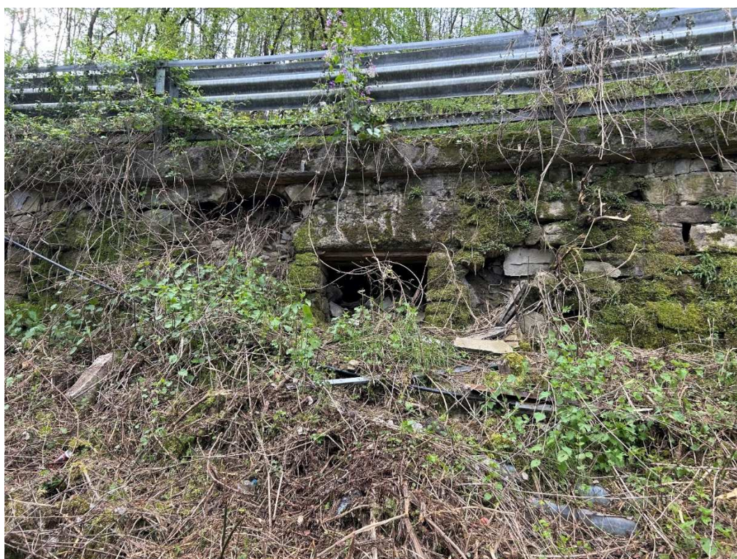
attraversamento esistente allo stato attuale da chiudere in fase di progetto
