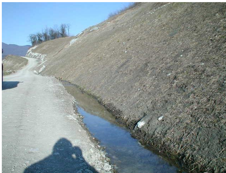
Figura 2.1 – Esempio di canaletta lungo i gradoni
