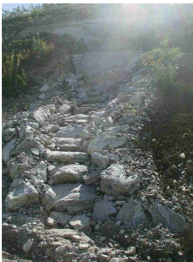
Figura 2.2 – esempio di canalette lungo tratti a forte pendenza
