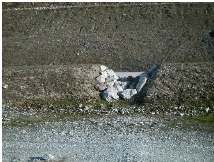
Figura 2.3 – esempio di canaletta rivestita in un tratto pianeggiante
