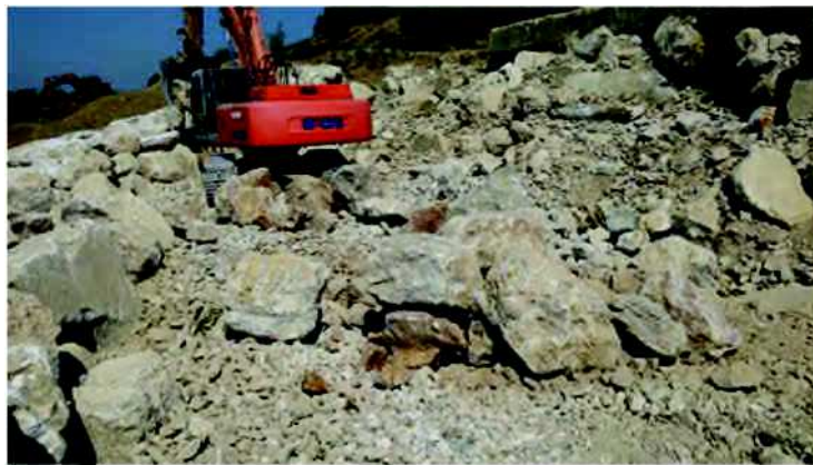
Fig. 6 Ricostruzione della scogliera sopra lo strato di materiale di cava
