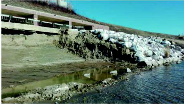
Fig. 5 Smontaggio della scogliera originaria
