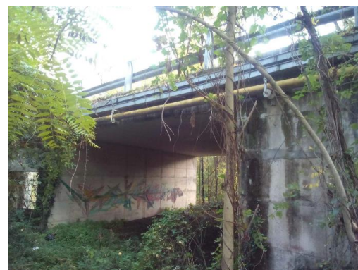
Vista percorrenza spondale sotto il ponte
