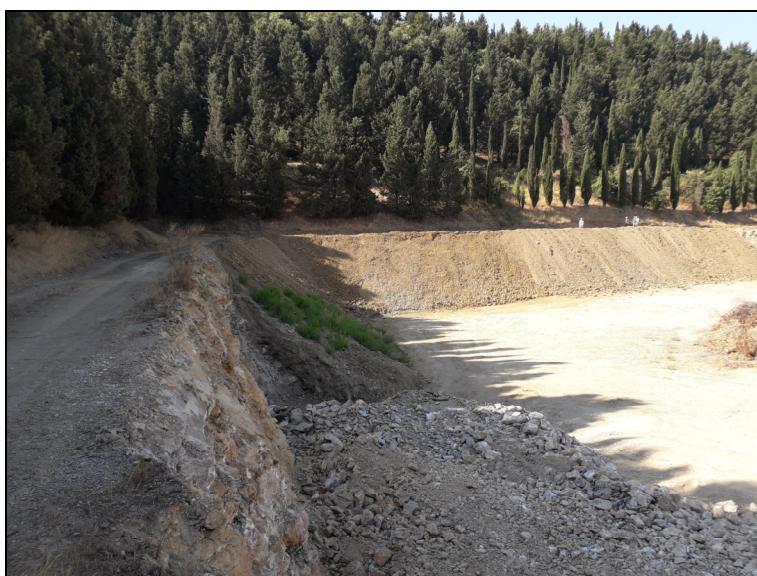
Fotografia 2: varie fasi di coltivazione nel settore SE del giacimento. In primo piano, il fronte di scavo col materiale abbattuto al piede. Sullo sfondo: ricarico con terreno vegetale del fronte Sud.
