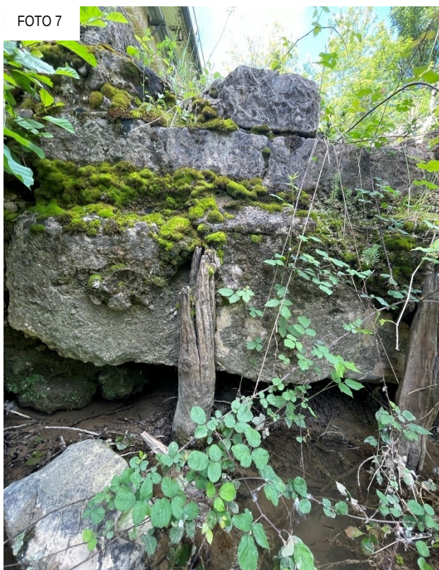
Figura 6.28: Dettagli dello scalzamento del muro e dei dissesti
