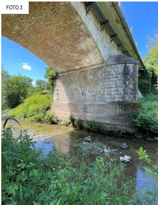
Figura 4.3: pila centrale e particolari dello scalzamento delle fondazioni
