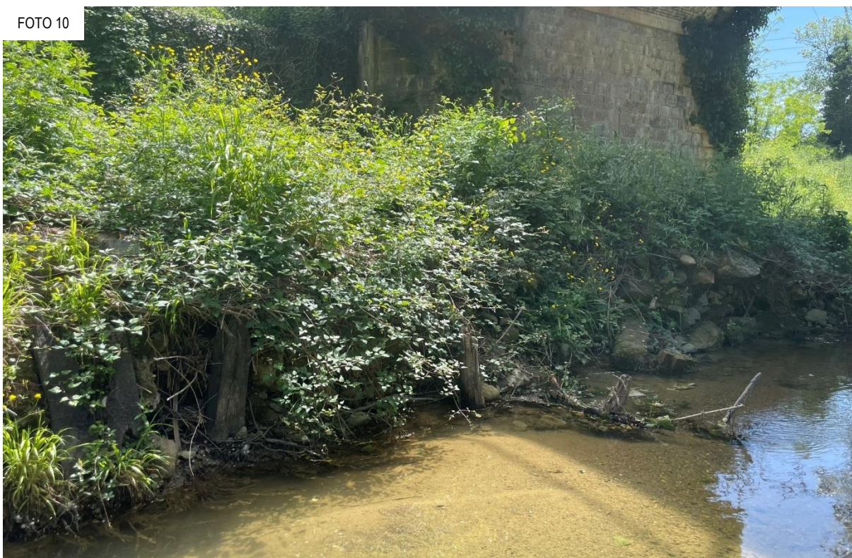
Figura 4.7: dettagli scalzamento della sponda in sinistra idraulica
