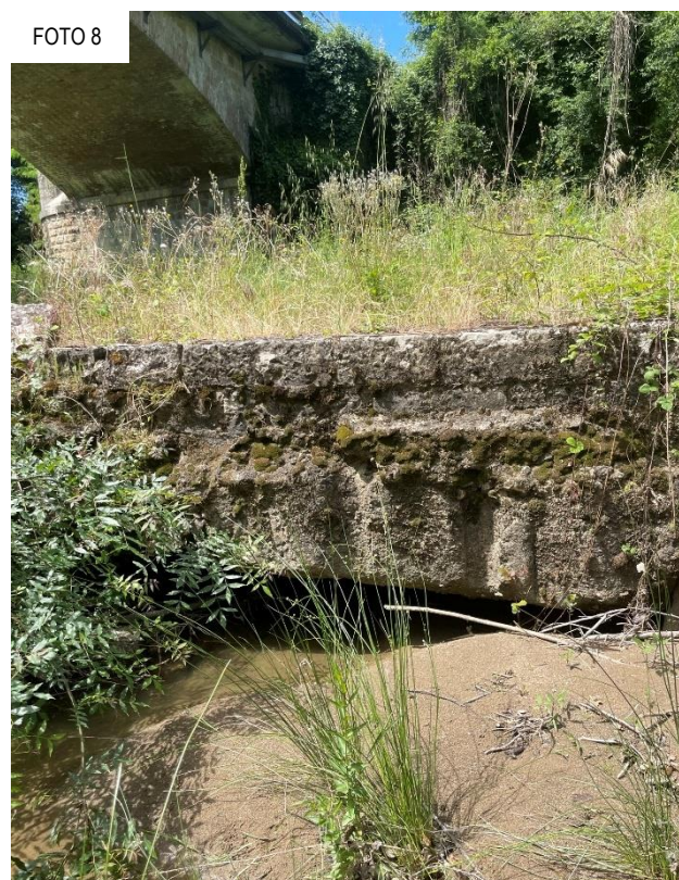
Figura 4.5: Dettagli dello scalzamento del muro e dei dissesti
