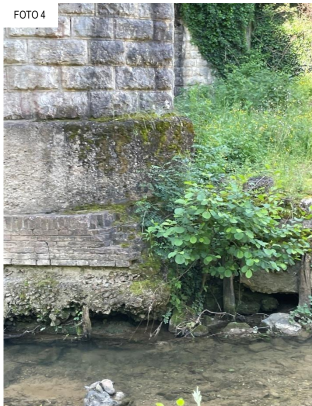
Figura 4.3: pila centrale e particolari dello scalzamento delle fondazioni
