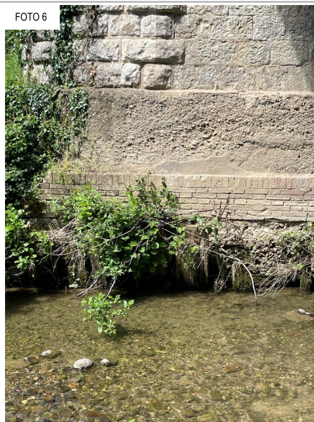
Figura 4.4: pila centrale e particolari dello scalzamento delle fondazioni
