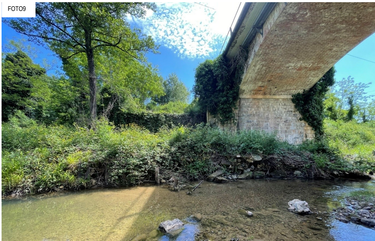
Figura 6.29: scalzamento della sponda in sinistra idraulica
