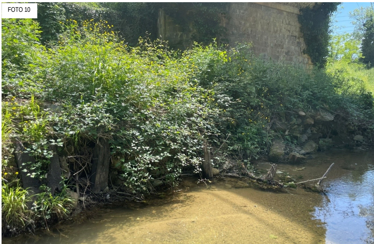
Figura 6.30: dettagli scalzamento della sponda in sinistra idraulica
