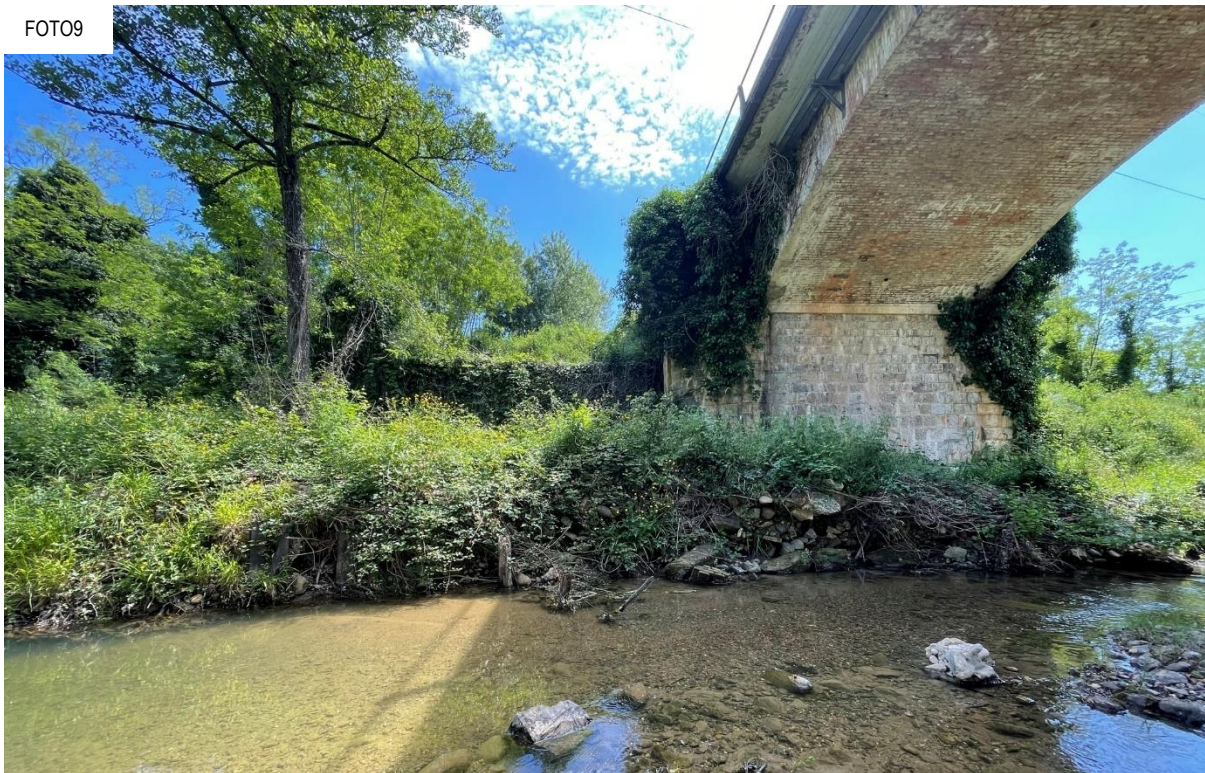
Figura 4.6: scalzamento della sponda in sinistra idraulica
