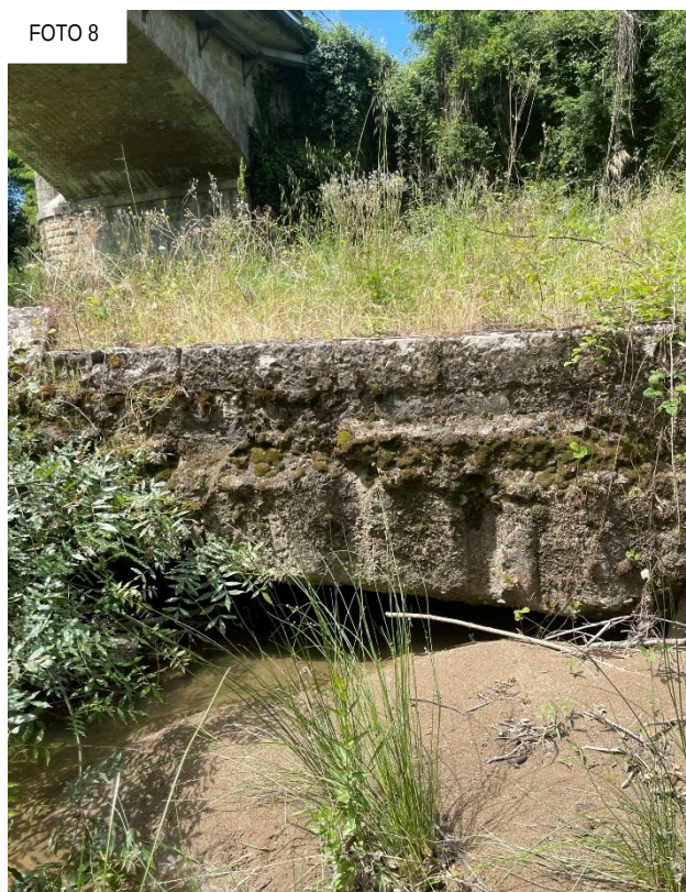
Figura 6.28: Dettagli dello scalzamento del muro e dei dissesti
