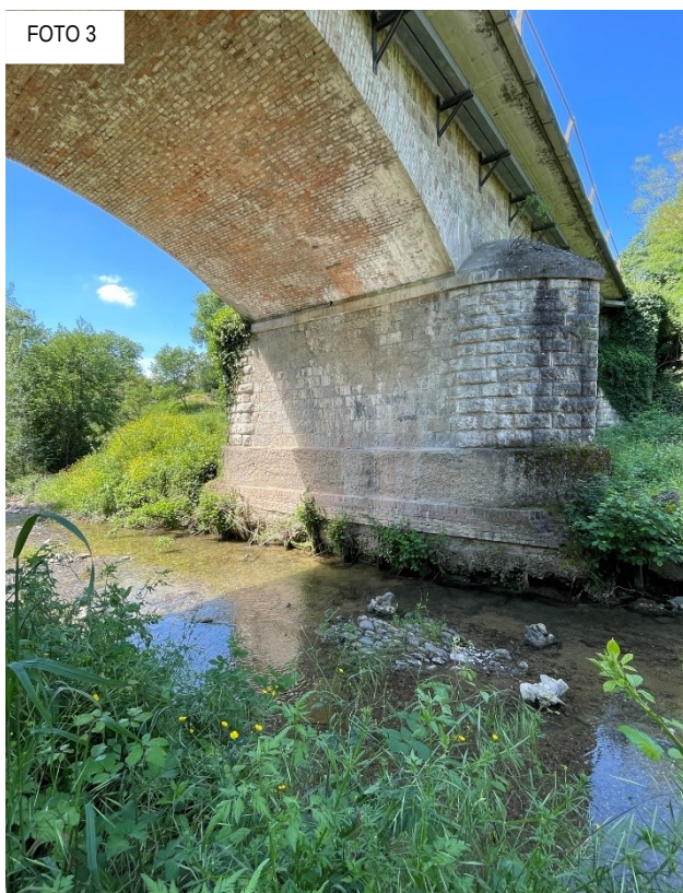
Figura 6.26: pila centrale e particolari dello scalzamento delle fondazioni
