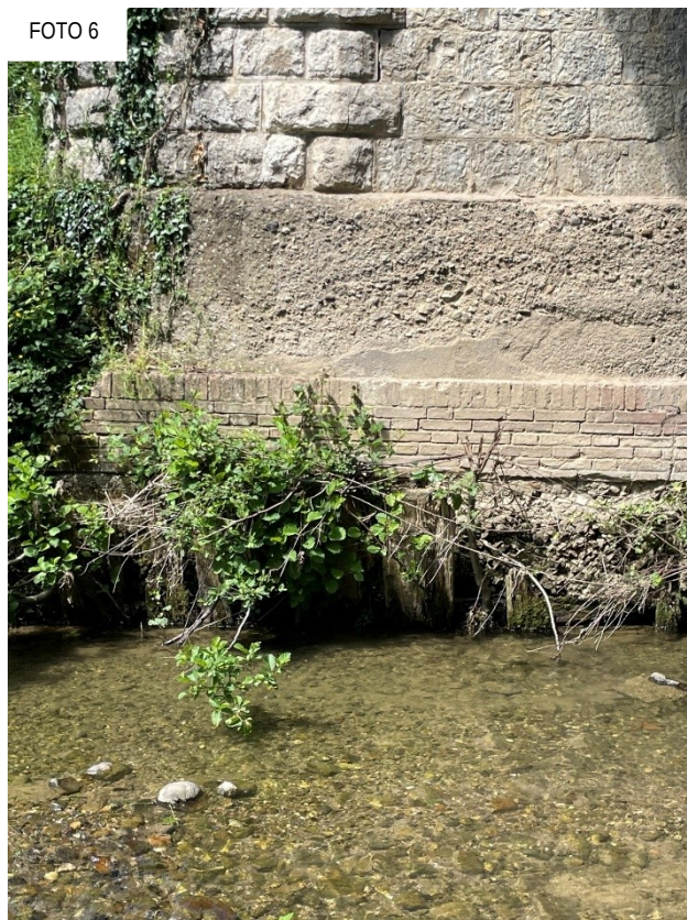
Figura 6.27: pila centrale e particolari dello scalzamento delle fondazioni
