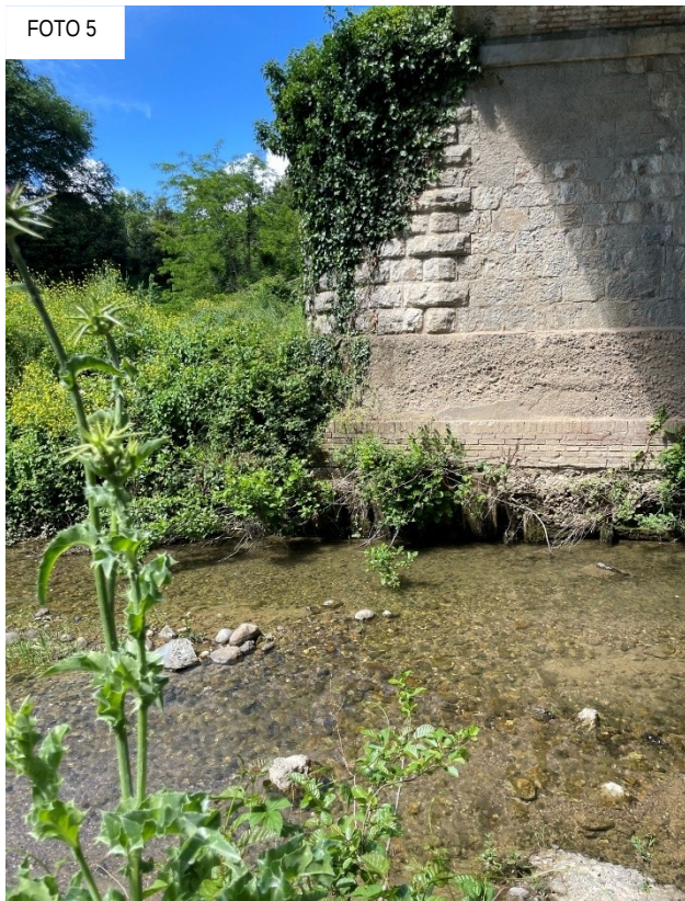
Figura 6.27: pila centrale e particolari dello scalzamento delle fondazioni
