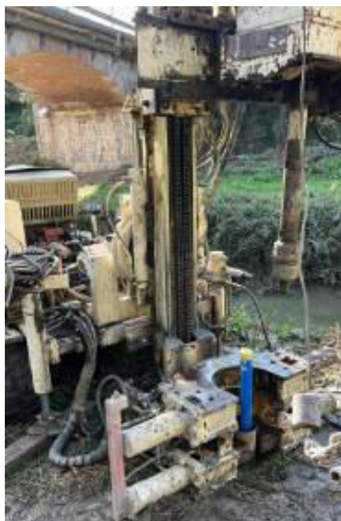
Installazione piezometro
