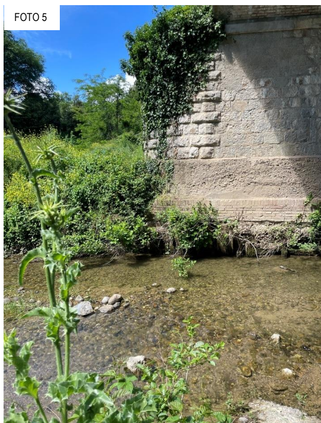
Figura 4.4: pila centrale e particolari dello scalzamento delle fondazioni
