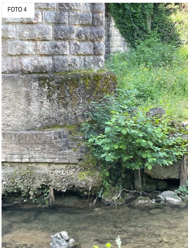
Figura 6.26: pila centrale e particolari dello scalzamento delle fondazioni
