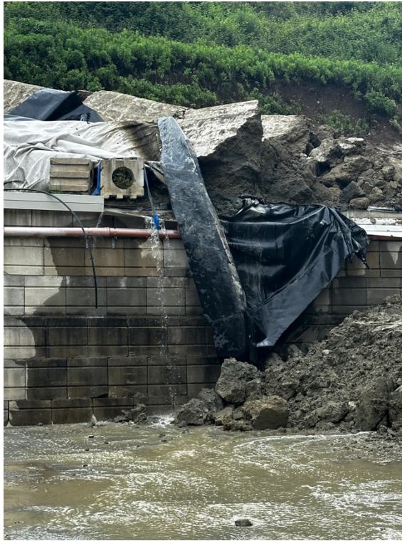
Figura 3 - Cedimento locale del paramento esterno incompleto
